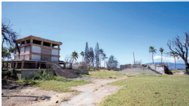
ラハイナ浄土院被災状況
